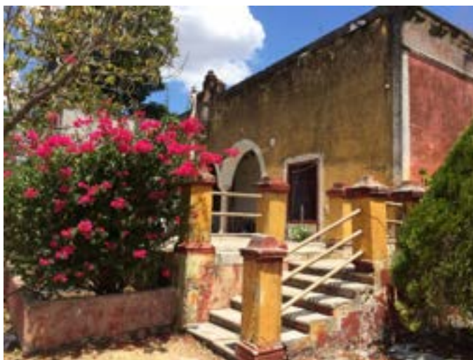
Ilustración 48. Exterior de uno de los edificios principales.
