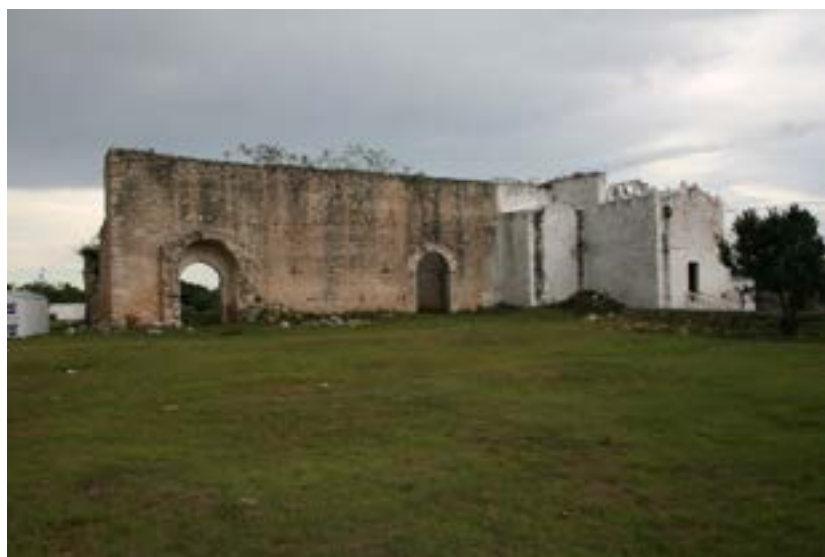
Ilustración 5. Vista exterior del edificio.
